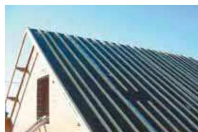
Si consiglia la posa dell'isolante in senso verticale, in particolare per quanto riguarda gli interassi dei travetti di 500 o 750 mm. Negli altri casi: aggiungere un travetto intermedio oppure eseguire la posa in senso orizzontale.
