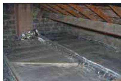
Per i solai inagibili: l'isolamento dovrà essere eseguito dal soffitto, dalla parte inferiore delle travi. La finitura potrà essere eseguita con pannelli di cartongesso o perlinato.
