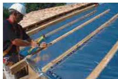
Si consiglia la posa dell'isolante in senso verticale, in particolare per quanto riguarda gli interassi dei travetti di 450 o 700 mm.
